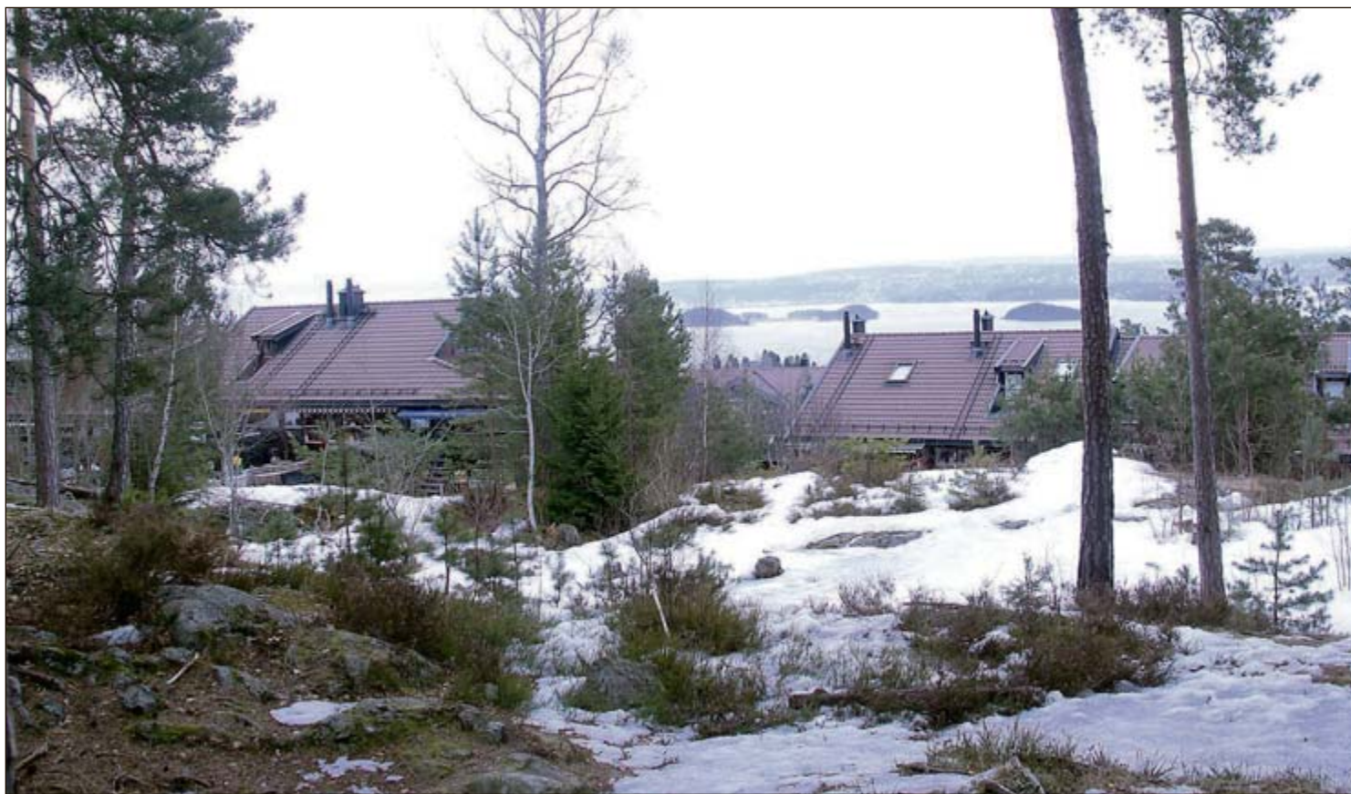
Det vil med stor sannsynlighet bli et økende press for fortetting og utbygging på arealer i Nesodden kommune, som dette på toppen av Tangenåsen bak Blomstervei- og Blåbærsti-grenda, grunnet forventet stor befolkningsvekst og tilsvarende økende boligbehov i Osloområdet.
